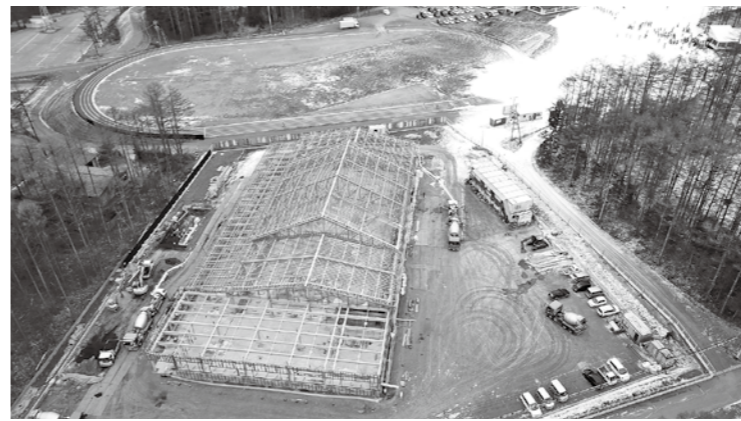
上空から見た湯の丸高原高地トレーニング施設
