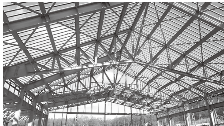
建設中の湯の丸高原屋内運動施設
