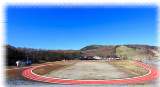
▲湯の丸高原スポーツ交流施設の 400m トラック
