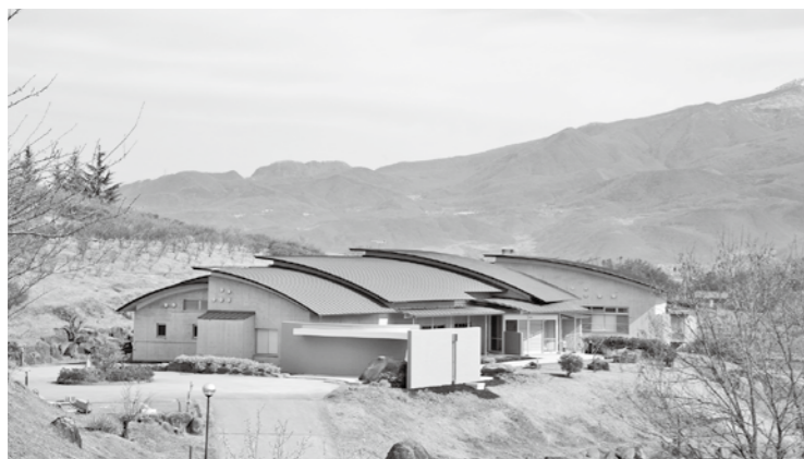
改修工事が終了した明神館
