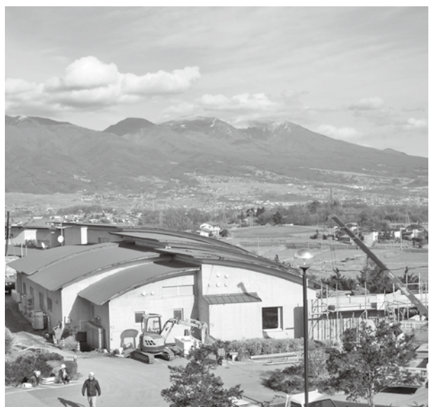
改修工事中のアートヴィレッジ明神館
