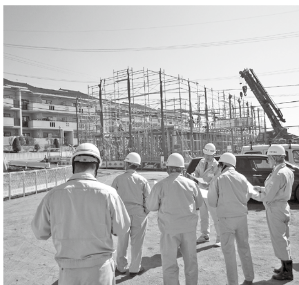
建て替え中の日向が丘市営住宅団地を視察
