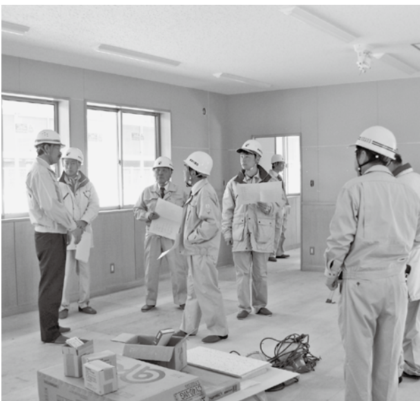
田中小学校普通教室増設工事の現地調査
