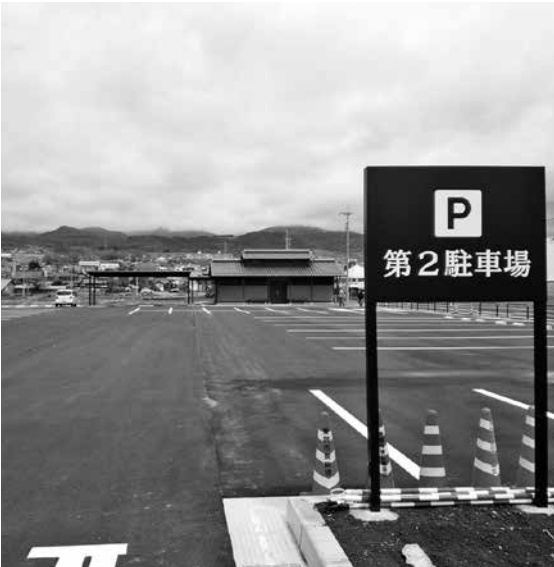
新設となった海野宿第2駐車場
