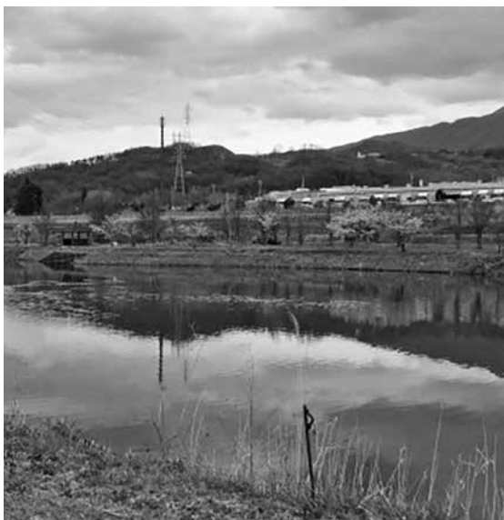
耐震性調査を実施した深井池
