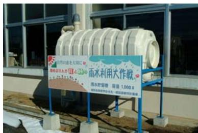
写真 6-8：雨水貯留槽
