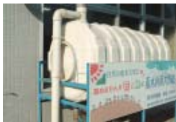
▲雨水貯留槽
