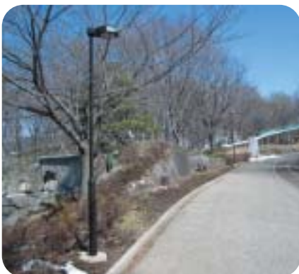
▲中央公園に設置されたLED照明
