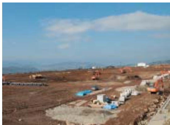
▲浅間サンライン鞍掛交差点付近に造成中の鞍掛工業団地
