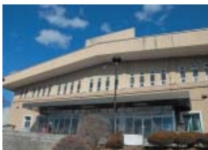
▲耐震補強工事が行われる第2体育館
