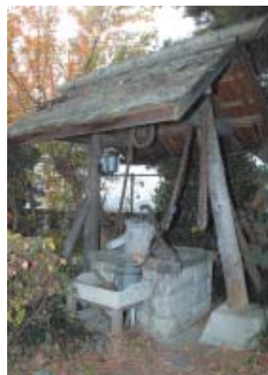
ののう屋敷に残されている井戸跡
