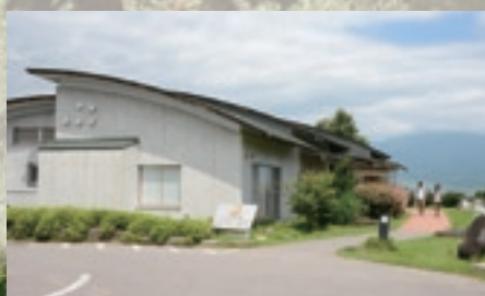
◀改修を実施する 「明神館」
