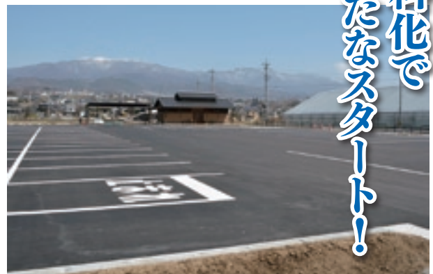
▲新設した海野宿第2駐車場
