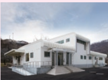
▲完成した新しい給食センター
