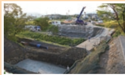
▲進む県東深井線道路改良工事
