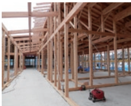
▲建設中の田中保育園には市有林の木材を使用しています
