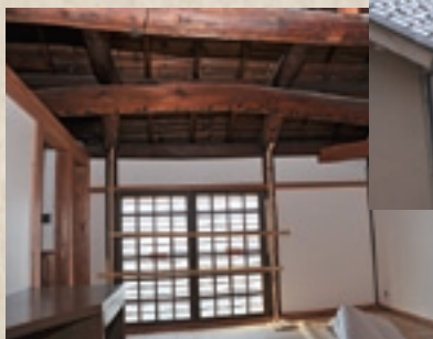
▲宿泊棟の室内
