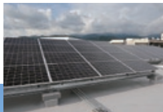
▲市役所本館屋上のソーラーパネル
