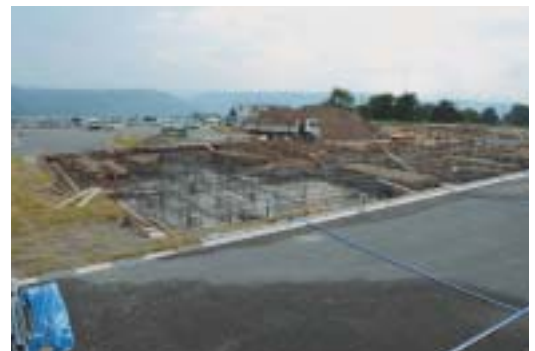
▲建設中の滋野地区保育園
