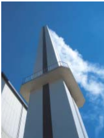
▶東部クリーンセンターの煙突から出る水蒸気
