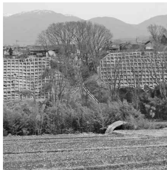
傾斜地対策で整備された赤岩地区
