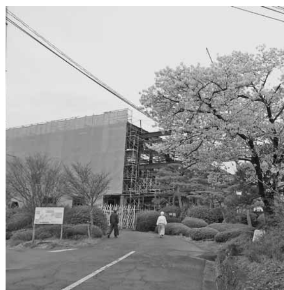
急ピッチで工事が進む市庁舎と新図書館
