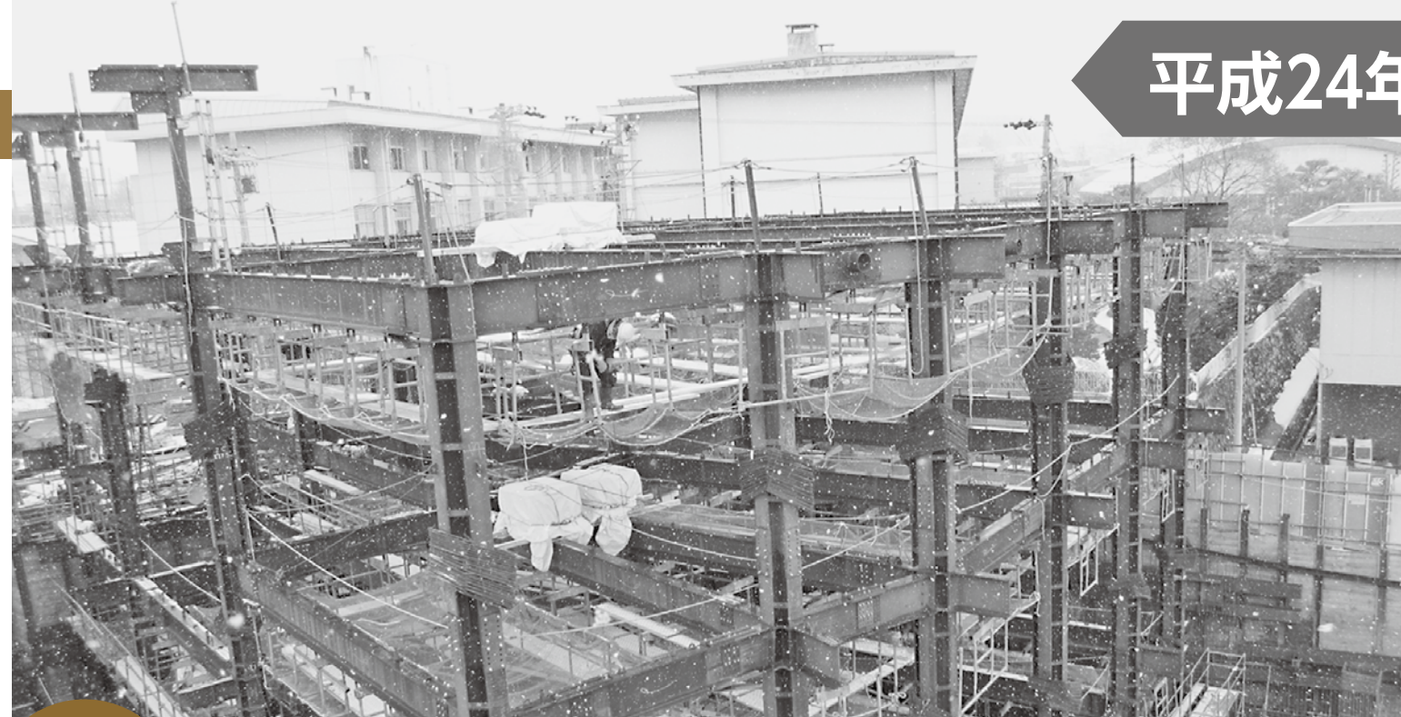
建設中の新庁舎・図書館
