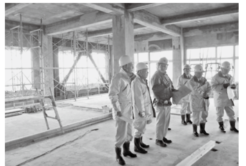
庁舎増改築工事の現地調査
