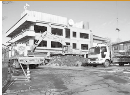
▶ 本庁舎増改築工事
