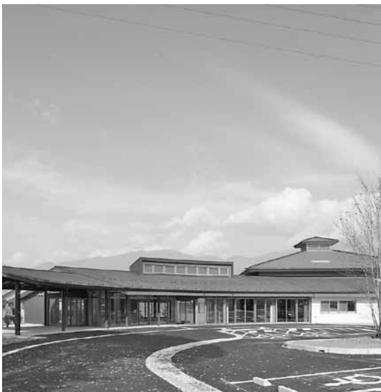
合併特例債を活用して建設された御牧乃湯
