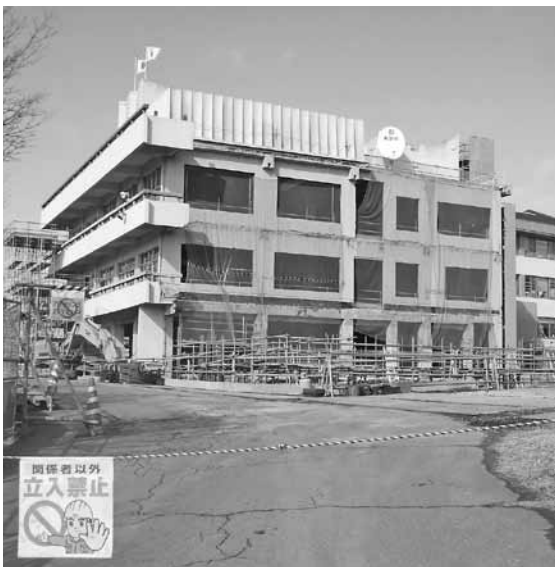
工事が進む市庁舎
