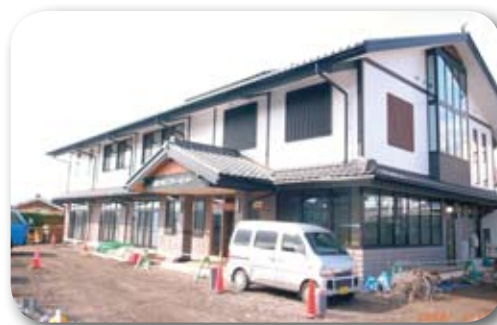
完成間近の滋野コミュニティセンター
