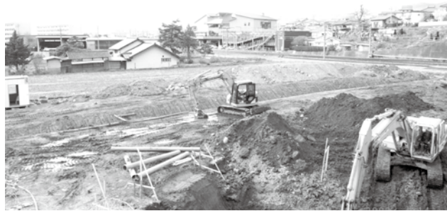
工事が始まった田中駅南口
