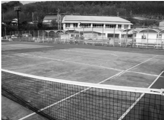
亀裂が入ったテニスコート
