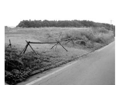
アスベストも埋められている聖の処分場
