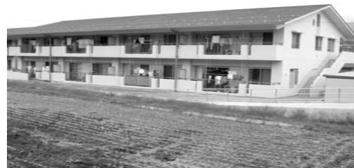
平成16年度に建設した羽毛山住宅団地
