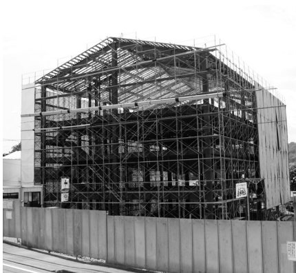
建設中の専門学校(田中)
