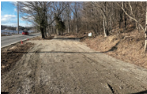
整備した駐車場の様子
