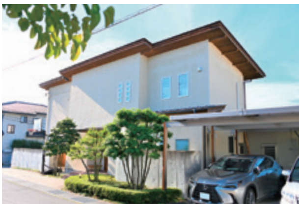
【名 称】 服部住宅 【所有者】 服部 正 【設計者】 開建築企画 櫻井秀夫 【施工者】 第一建設工業(株) 関根 実 【完成年】 平成19年
