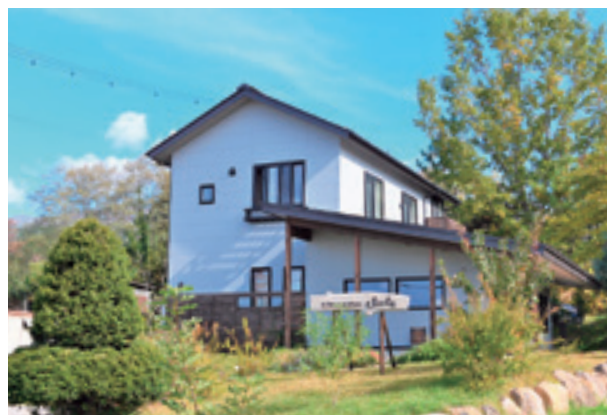
【名 称】 パンとお菓子クリシェ 【所有者】 渡邊武蔵 【設計者】 御代田建築設計事務所 山田まどか 【施工者】 ライツ建築研究所(有) 今井義幸 【完成年】 令和元年
