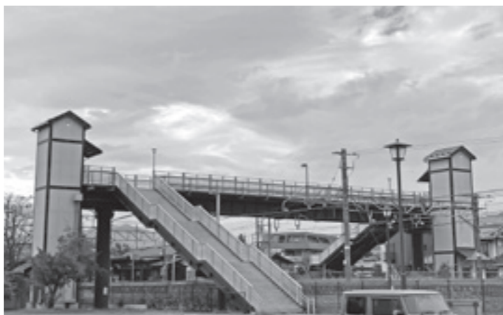
田中駅南北をつなぐ自由通路
