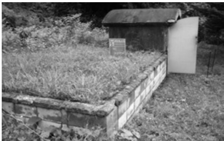
西宮水源（配水池）
