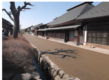
まちなみの色彩に合わせた道路舗装を施工
