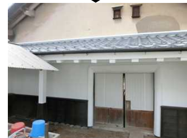
修理による建物の変化
