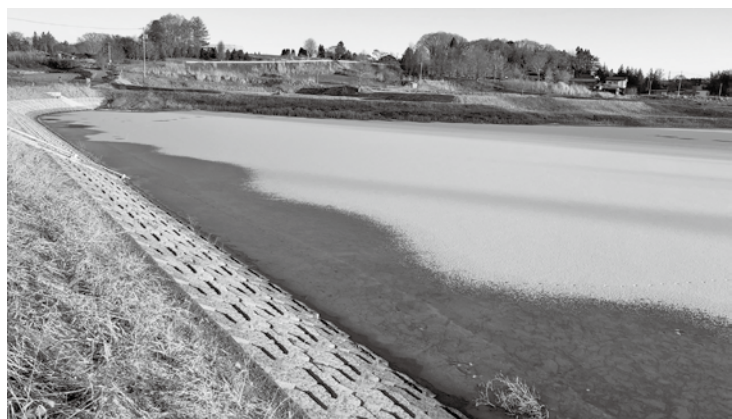
耐震工事を完了した四ツ京池
