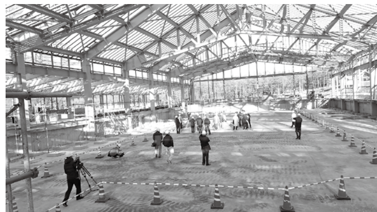
湯の丸高地トレーニングプールの現地説明会（12月1日）
