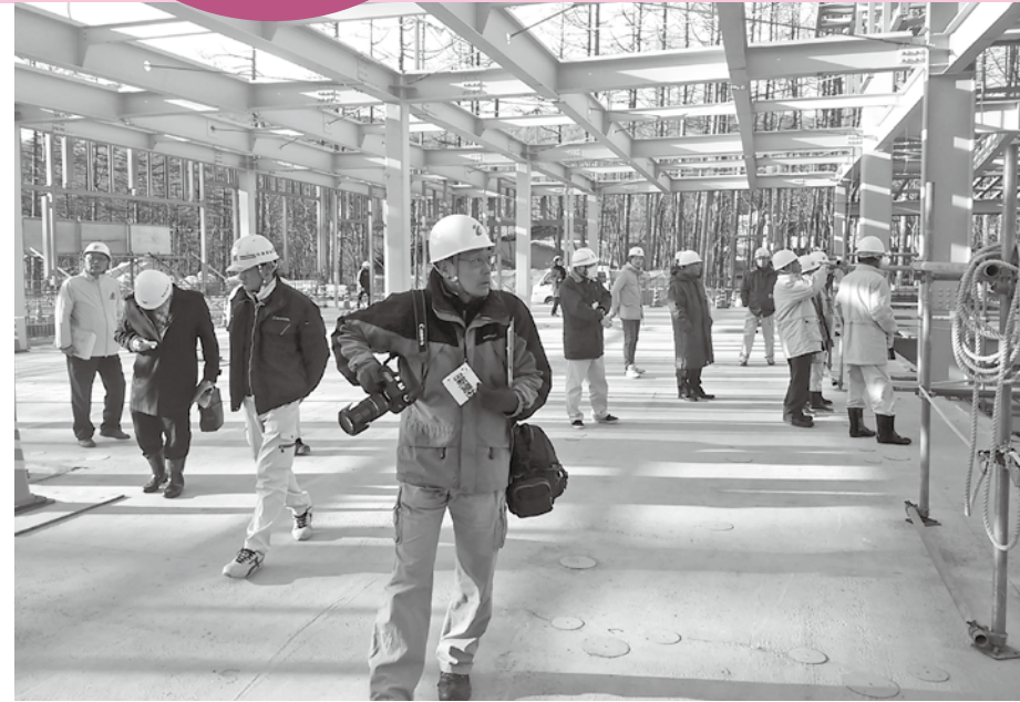
本格的な工事が進む湯の丸高原屋内運動施設（昨年12月の現地説明会）
