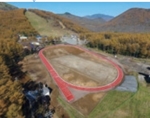
▲完成した400mトラック
