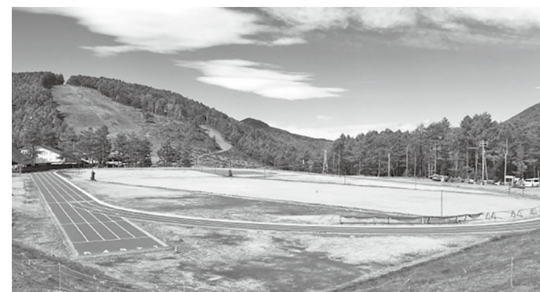
今建設中の湯の丸高原トレーニング施設（平成29年10月1日現在）
