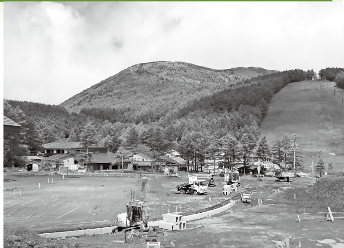
湯の丸高原400mトラック工事状況
