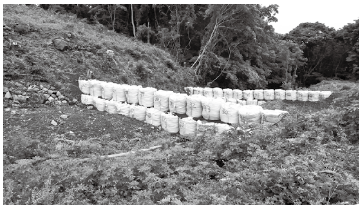
設置された仮砂防堰堤（御堂沢川東側支流）
