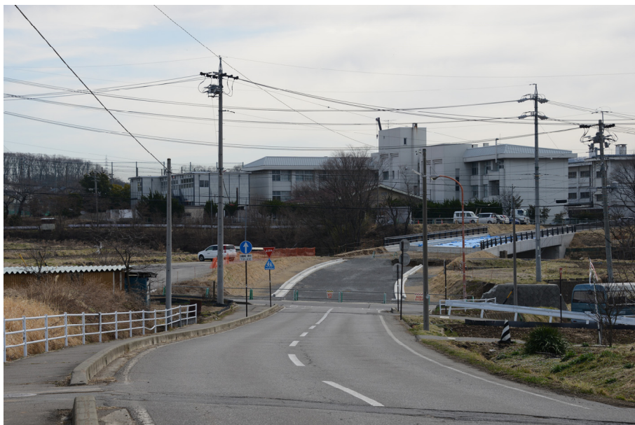
建設中の県・東深井線
