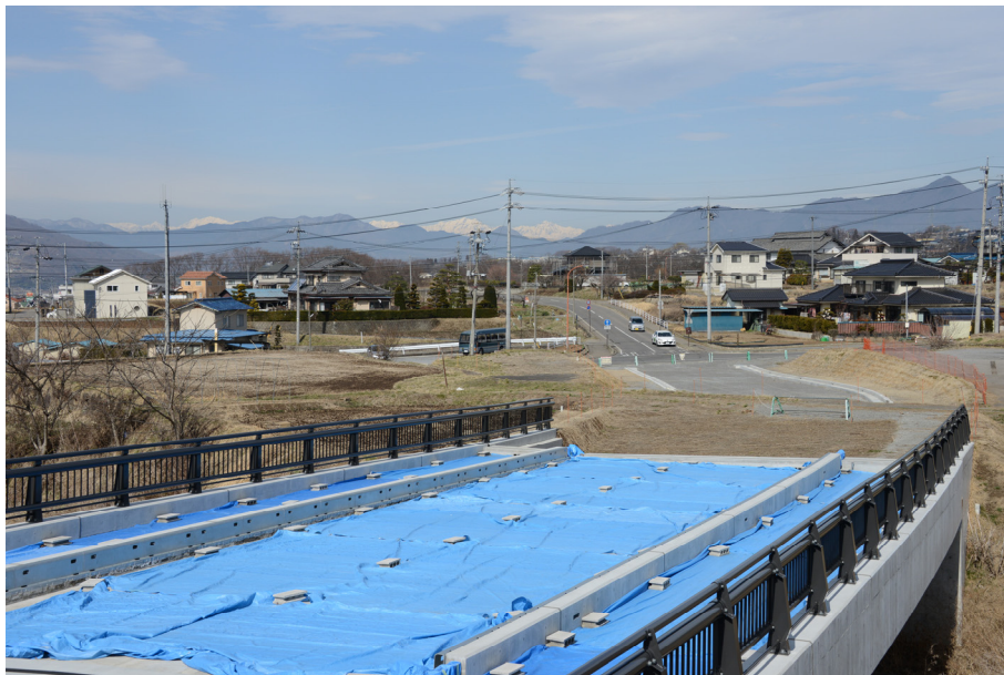
建設中の県・東深井線
